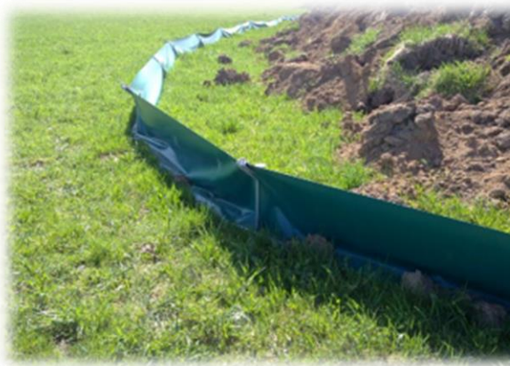
Photographie 23 : Exemples avec construction en porte-à-faux avec poteaux de retenue pour amphibiens et reptiles, coudés à 45° au-dessus pour protection antichute (Source : maibach.com)
