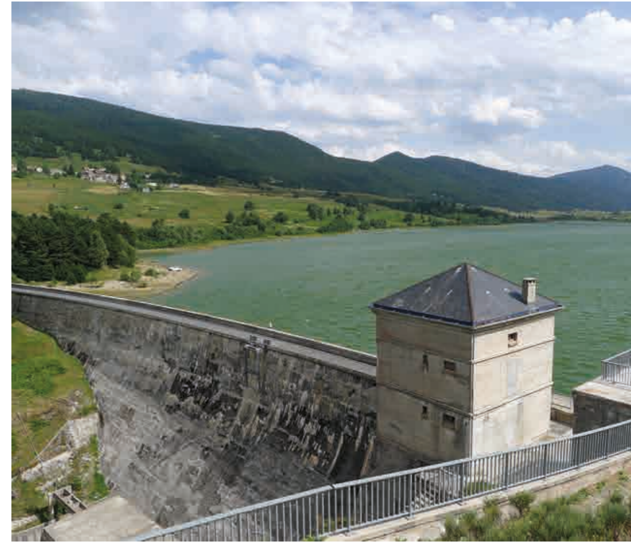
Retenue de Puyvalador
