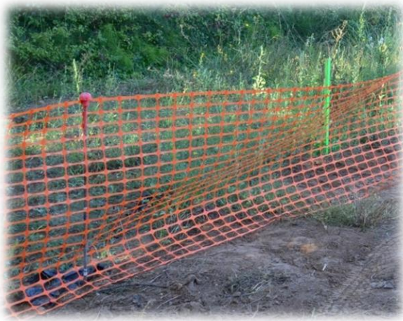
Photographie 21: Dispositif de limitation des emprises des travaux
