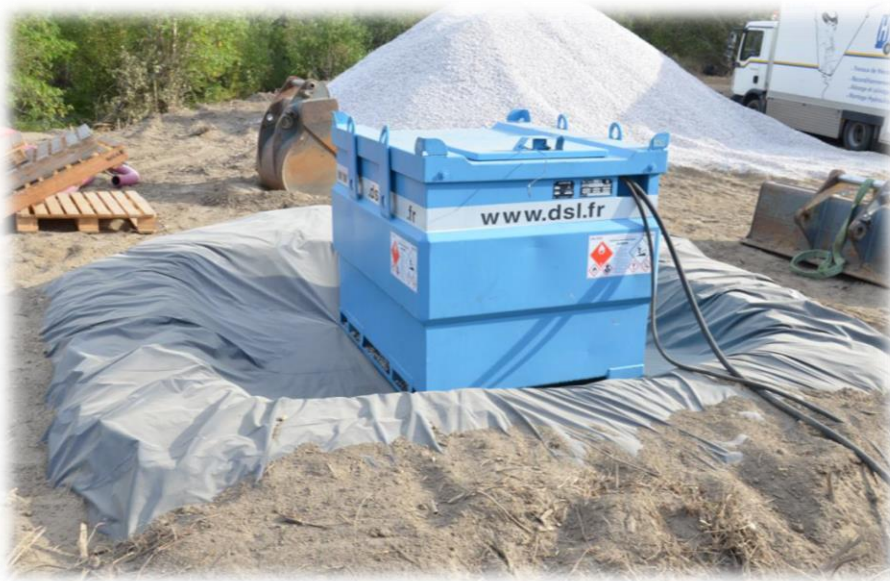
Photographie 22 : Mise en place d'une aire étanche autour d'un groupe électrogène
