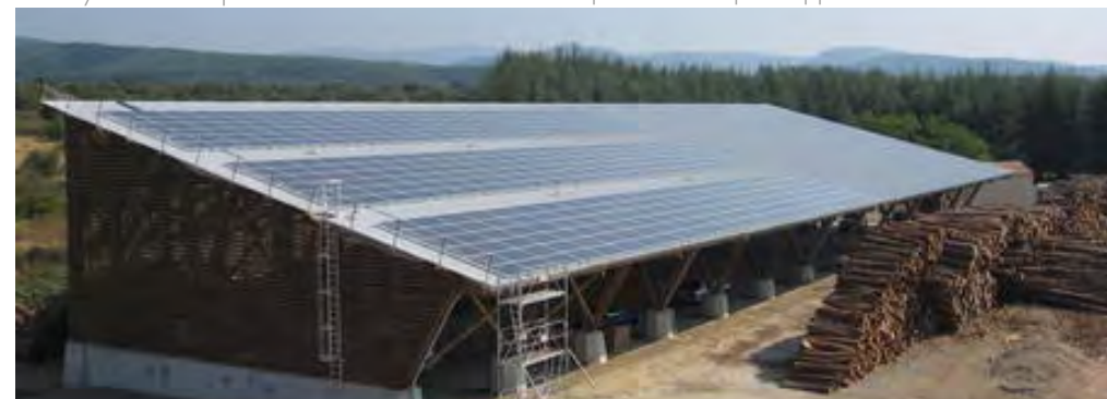
Mix énergétique : stockage bois et photovoltaïque
