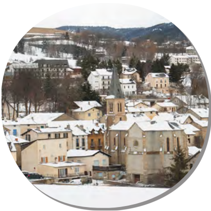
Une opération d'envergure pour la rénovation du bâti
